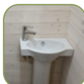
Установка раковины в санузле с подводкой
