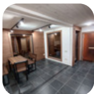
Пол — керамогранит с электрическим тёплым полом по всей бане
