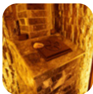
Отделка печного угла плиткой из талькохлорита с контурной подсветкой КОЛОТЫЙ КАМЕНЬ
