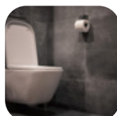
Установка инсталляции унитаза с подводкой
